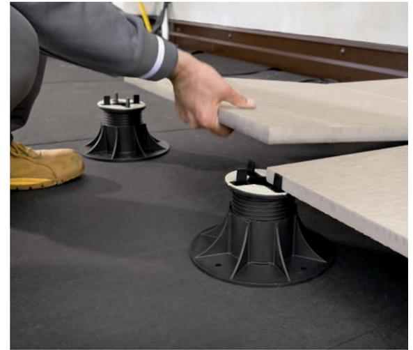
**PER UNA MIGLIORE STABILITÀ DELLA PAVIMENTAZIONE SOPRAELEVATA, SI SUGGERISCE L'IMPIEGO DI CINQUE SUPPORTI PER LASTRA.**
