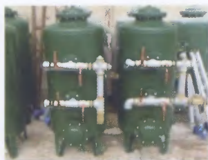
Filtri a colonna (carboni attivi o sabbia di quarzo) con sistema di controlavaggio manuale o automatico.
