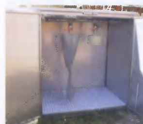
Fase di trattamento fanghi Camera di disidratazione fanghi in acciaio inox a manichette drenanti.
