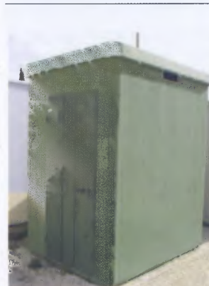
Locale tecnico prefabbricato in c.a.v. per alloggiamento apparecchiature e accessori impianti di trattamento.
