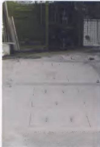
Particolare botole copertura
