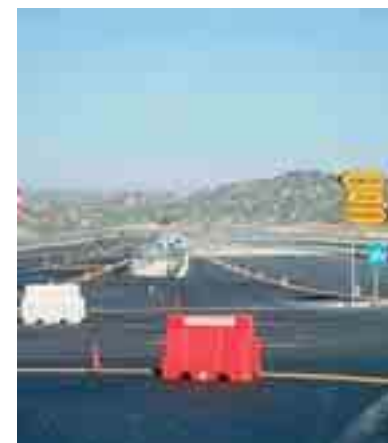
LAVORI DI RADDOPPIO DELLA SS 640
